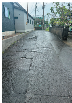
写真 個人の土地である「公衆道路」
